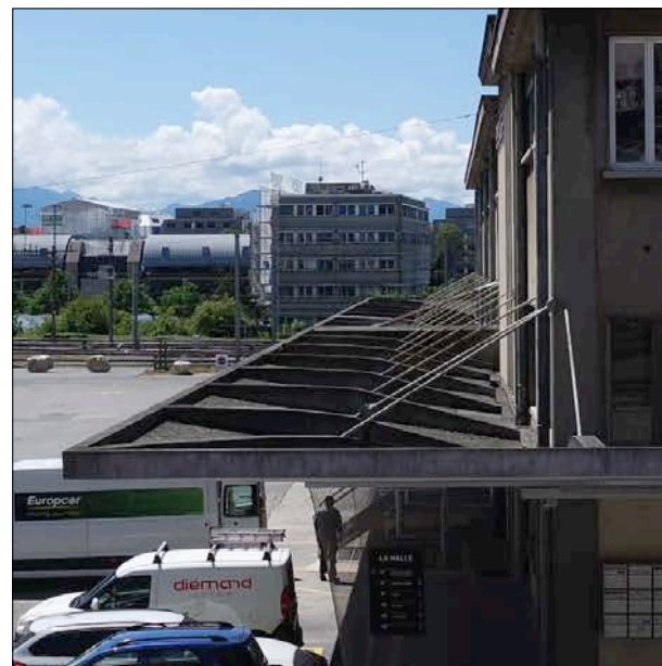
② Auvents en béton en porte-à-faux
