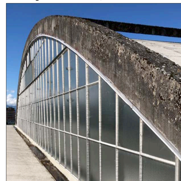
⑯ Vitrage Arche en béton, tirant
