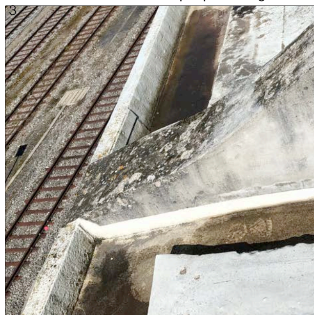
① Détail arc de liaison sud/plaque avec gouttière
