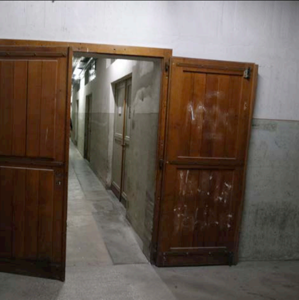
Porte coupe-feu du sous-sol dans le couloir
