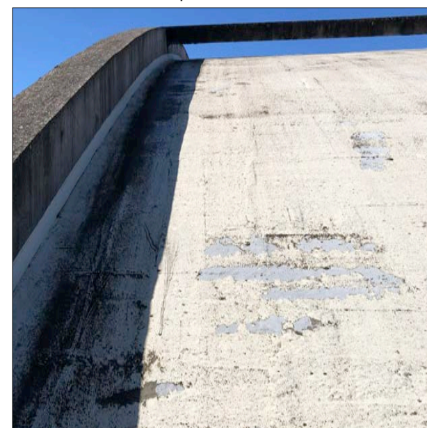
⑭ Arc de toit avec plusieurs couches d'étanchéité
