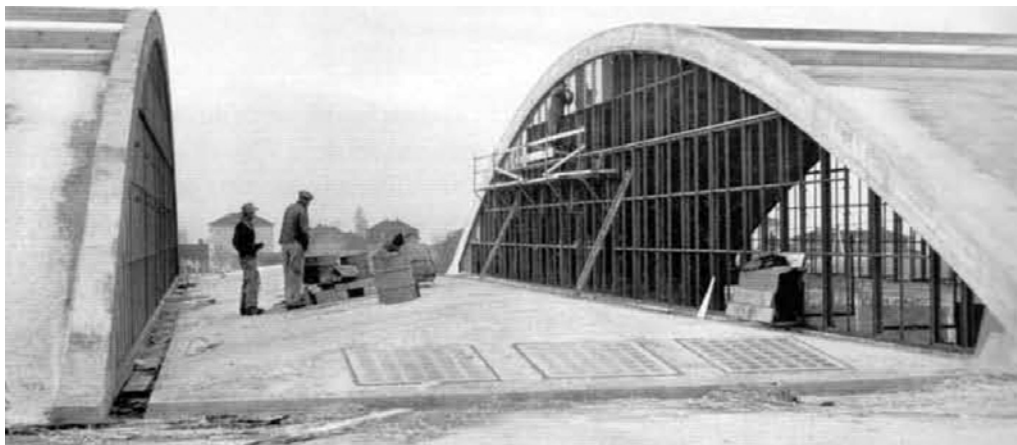
Fig. 6: Vitrage des arcs vers 1953, Source: GEA
