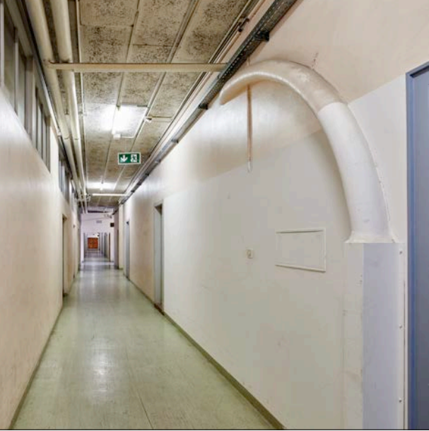
Système de tubes pneumatiques de l'étage supérieur
