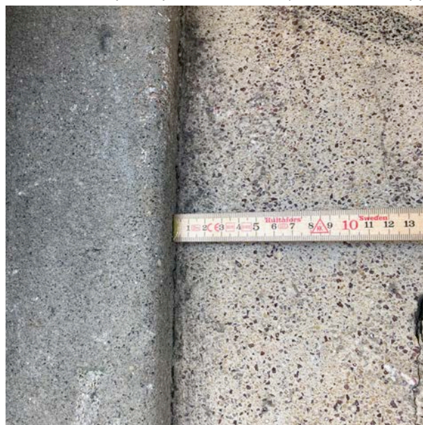
① Détail crépi de pierre bicolore (colonne/champ)
