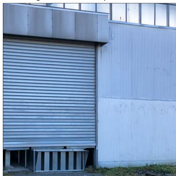
⑪ Bardage en tôle ondulée, portes à volets roulants
